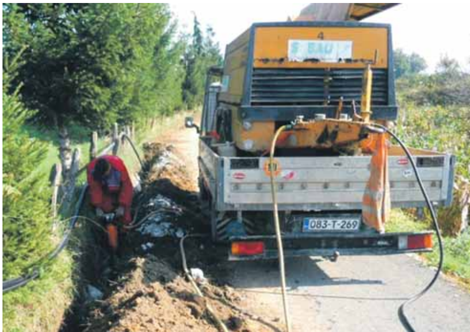
Изградња цјевовода у МЗ Рекавице 1
